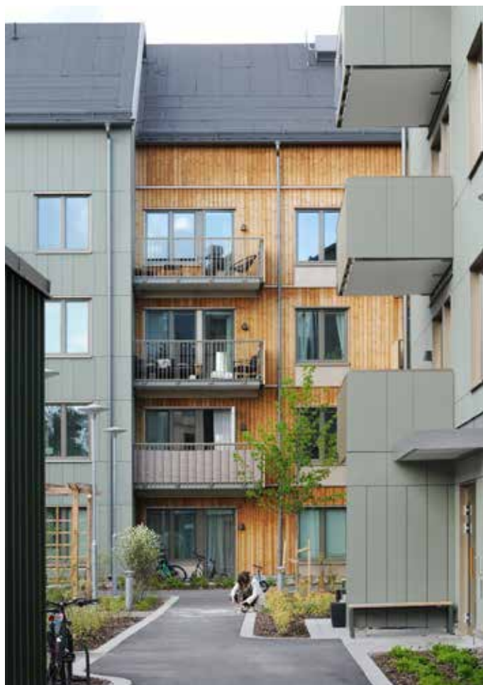
Referensbild från Kv. Jakt i Nyköping. Fasader i kombination av stående träpanel och skivmaterial. Arkitekt: Nordmark & Nordmark arkitekter. Foto: Pia Larsson
