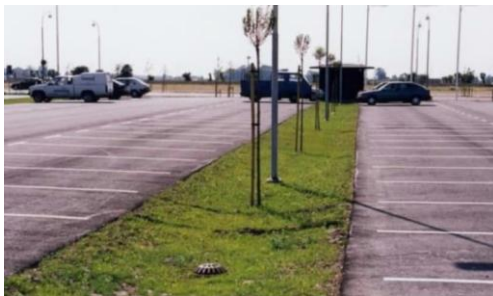
Figur 16. Exempel på svackdike (tv) och princip för tvåstegsdike (th) (Tyréns, 2024).
