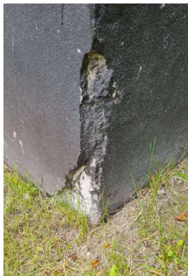
Bild 6 Sockel, bortfall av material i putsning
