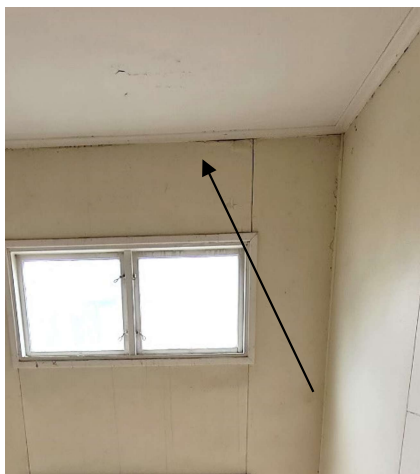
Bild 15 Exempelbild i trapphus
