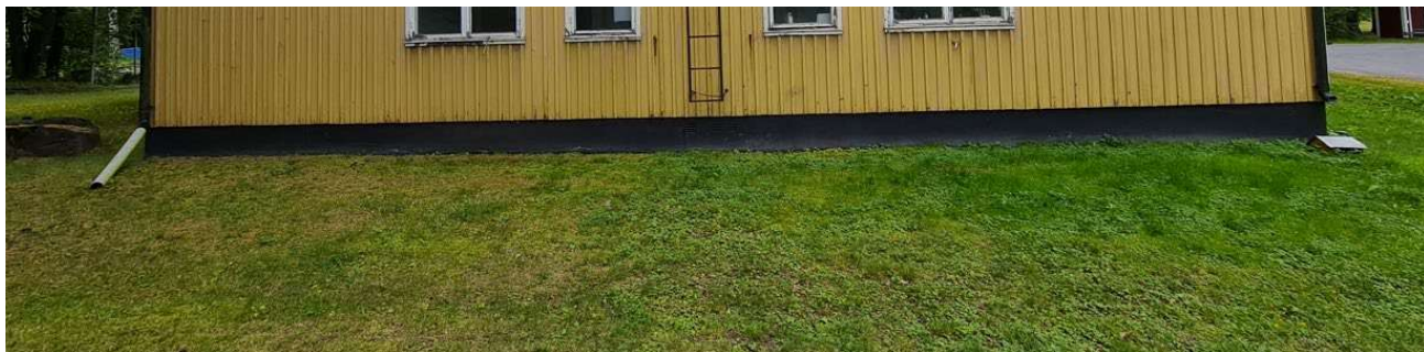
Bild 5 Mark utanför byggnad, Sandgatan 6.
