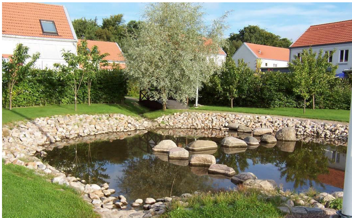
Öppen fördröjningsdamm (Mariastaden Helsingborg)
