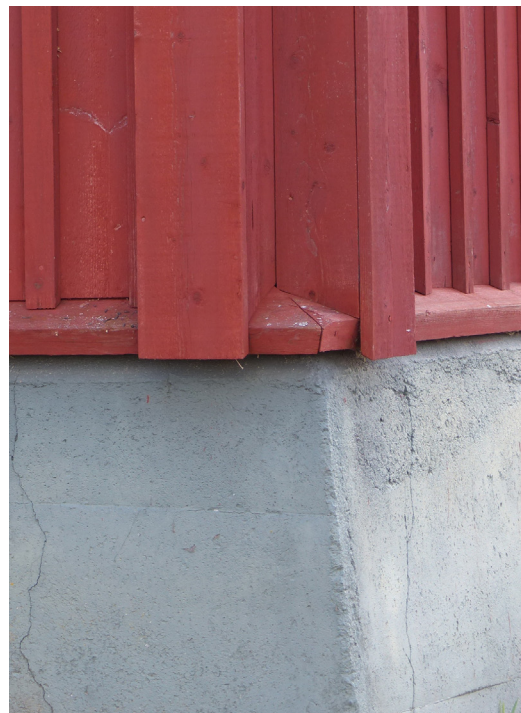
Löjtnantsbostaden är en panelklädd timring med sockel av pågjuten stengrund. Foto: Tyréns.
