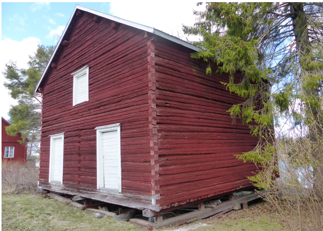
Härbre intill Löjtnantsbostaden. Foto: Tyréns.
