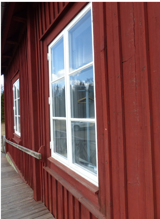
Locklistpanel där allt utom fönster och dörrar är målade med röd slamfärg. Foto: Tyréns.
